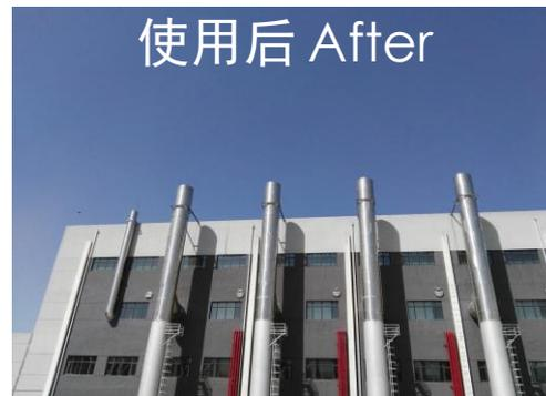
Éliminez la fumée blanche. La pompe à chaleur à absorption réduit les gaz d'échappement à 30°C, extrait plus de 80% de vapeur d'eau et réduit environ 25,2 t d'émission de vapeur d'eau pour chaque tonne de chaudière à chaque saison de chauffage (2900 h)
