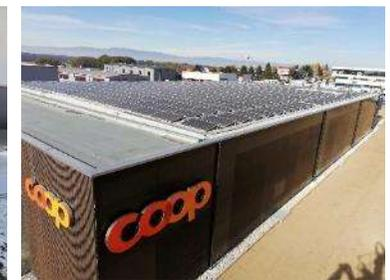
Installation doublement remarquable car elle associe le sous-refroidissement CO<sub>2</sub> par stockage latent à une installation photovoltaïque d'électricité.
