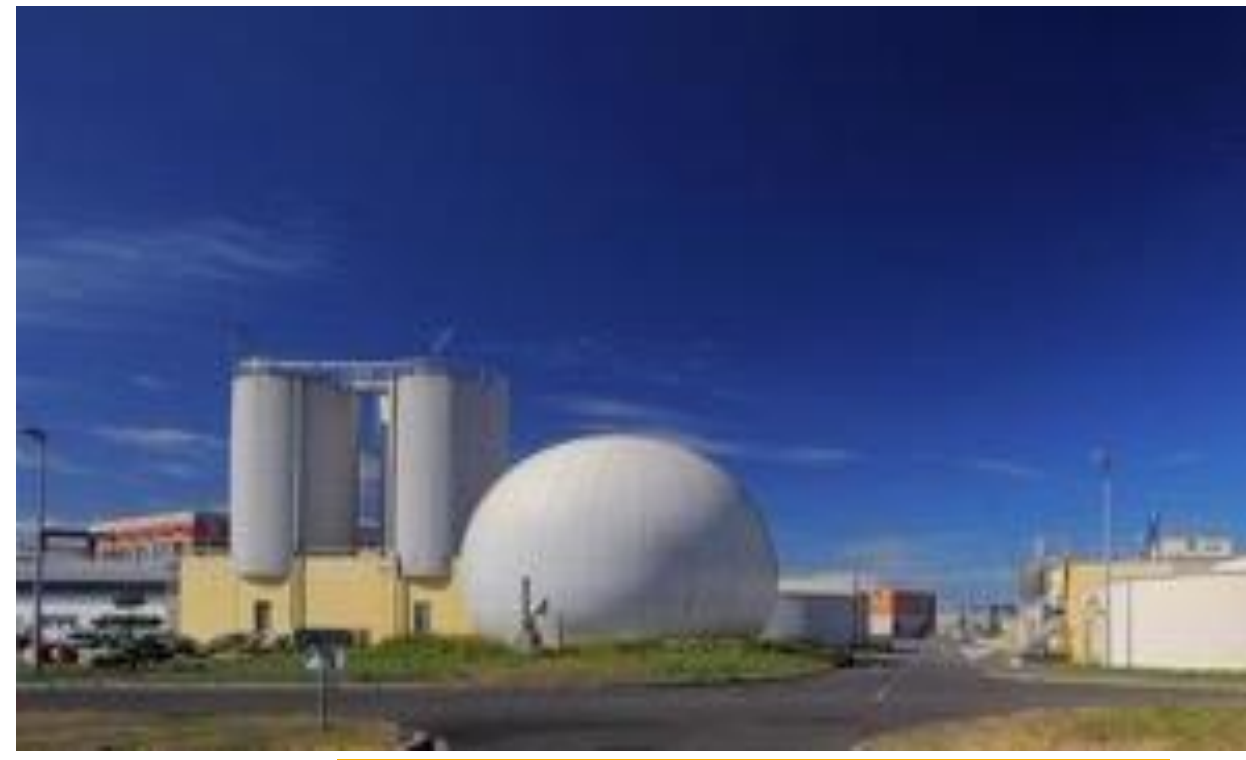
« Méthanisation de Boues de STEP »
