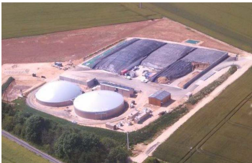
Figure 3 : L'installations de la SAS Valois Energie à Senlis (fin de construction en 2017)
