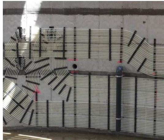
Figure 5 : Chauffage des digesteur & post-digesteur
