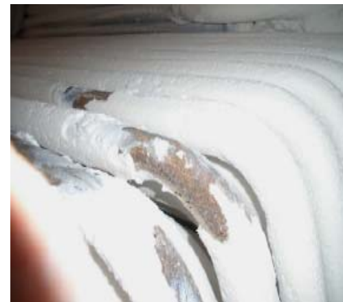
Figure 3 : Colmatage d'un échangeur de chaleur par des dépôts de silice \text{SiO}_2
