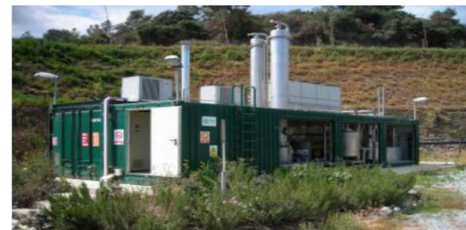
Unité d'épuration aux amines à Vacarisse (Espagne) ; Source : HeraCleantech
