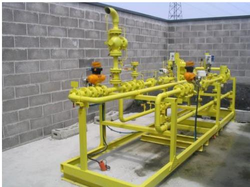
Figure 10 : Poste d'injection de biogaz épuré dans le réseau de distribution de gaz naturel – source Communauté Urbaine de Lille
