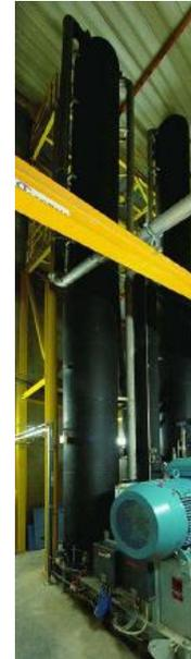
Figure 9 : Epurateur de biogaz du CVO
