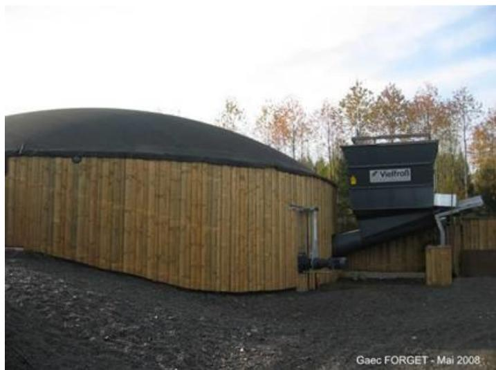
Figure 3 : La trémie d'incorporation - source AgriKomp
