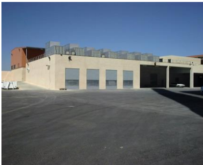
Figure 4 : Bâtiment Centrale Fluides (tours aéroréfrigérantes sur le toit)
